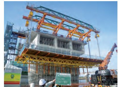
写真-2 移動作業車リフトアップ状況
