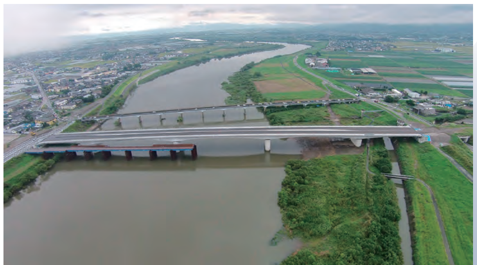
写真-1 完成写真
