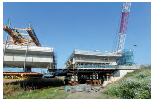
写真-5 2次施工部
