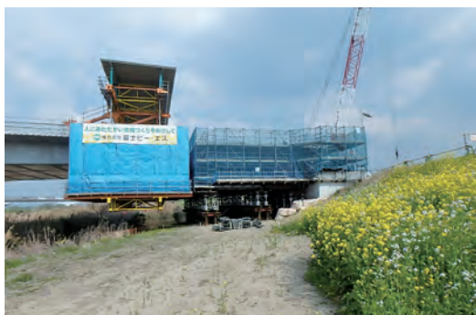
写真-4 1次施工部
