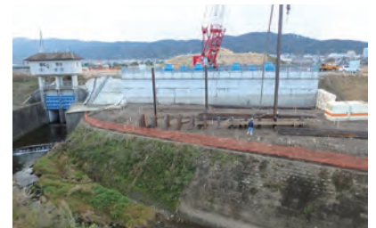
写真-3 H鋼杭施工
