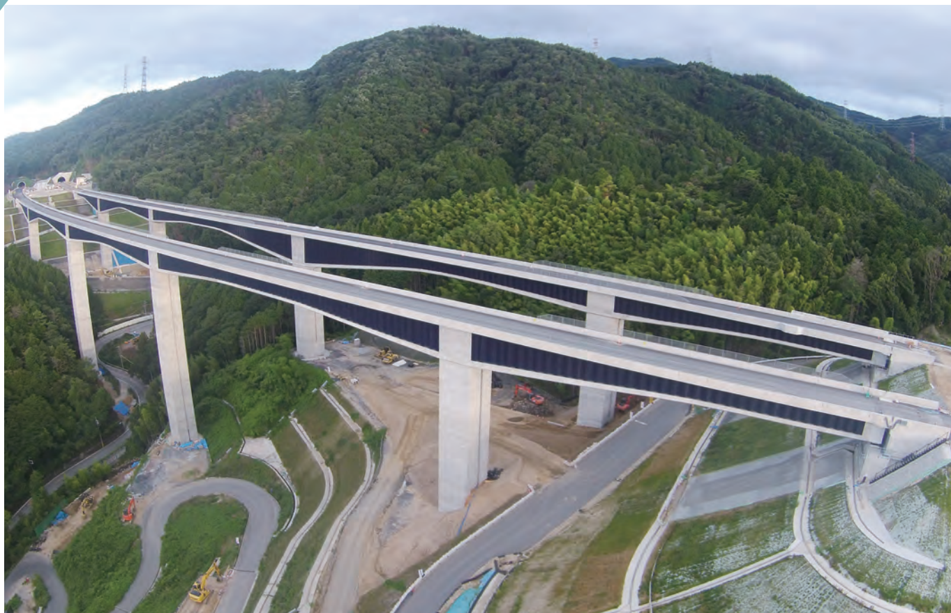
写真-1 佐保川橋
