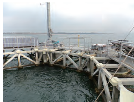
コンクリート部材の状況
