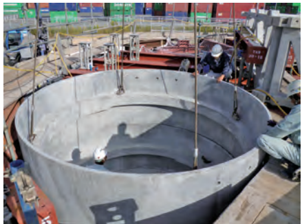
円筒浮力体組立状況
