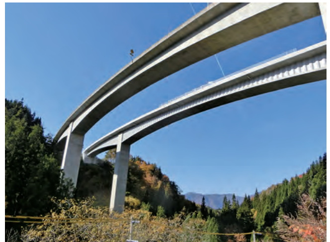
写真-2 八百僧橋完成写真
