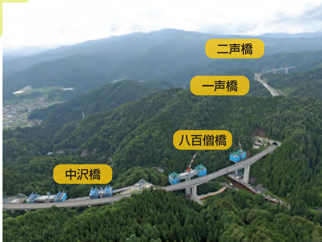
写真-1 施工状況
