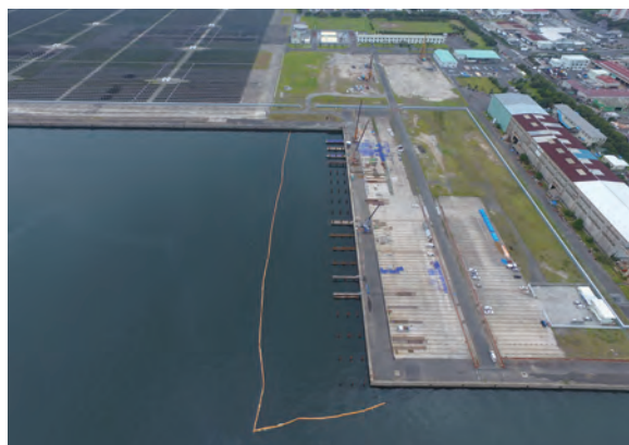
PC上部工施工前
