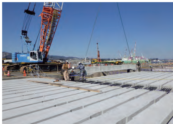
PCホロー桁架設
