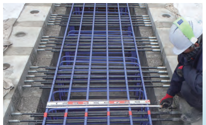
写真-2 機械式継手による配筋の工夫
