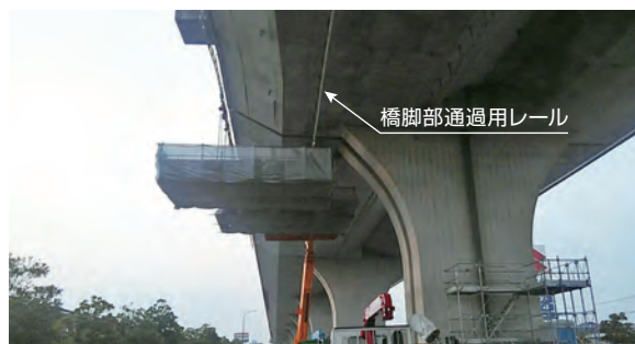
写真-4 橋脚周辺での吊足場の移動状況
