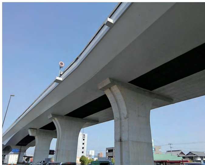
写真-1 施工完了
