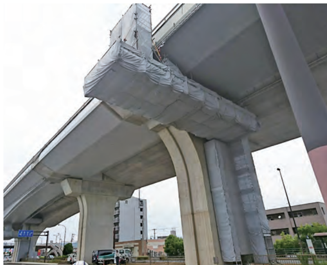
写真-2 移動式吊足場による施工状況
