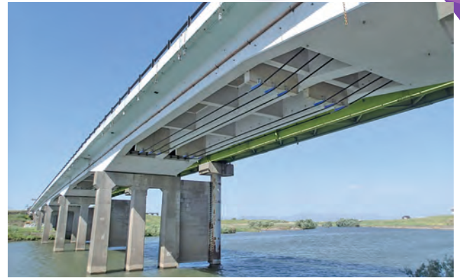
千歳橋全景(補修工事完了後)
