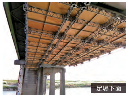
図-4 先行床施工式フロア型システム吊り足場
