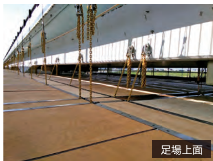
図-4 先行床施工式フロア型システム吊り足場
