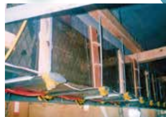
写真-1 パネル法による脱塩状況例
