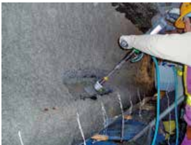
◀削孔機による コンクリート・コア採取
