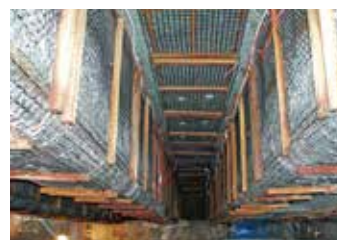
写真-2 ファイバー法で天井、桁底も脱塩対象部位とした例
