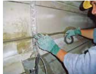
写真-5 リボンメッシュ陽極設置状況
