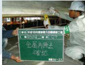
写真-4 金属片除去確認状況
