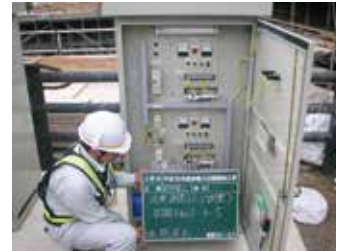
写真-6 通電調整を行った後
