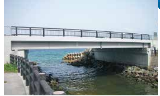
写真-1 工事完了
