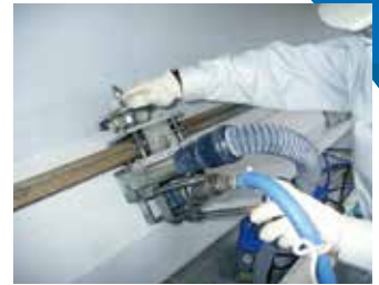
写真-2 溝切作業状況
