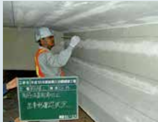
写真-3 深さ確認状況
