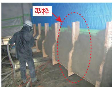
写真-4 鉄筋背面の吹付け
