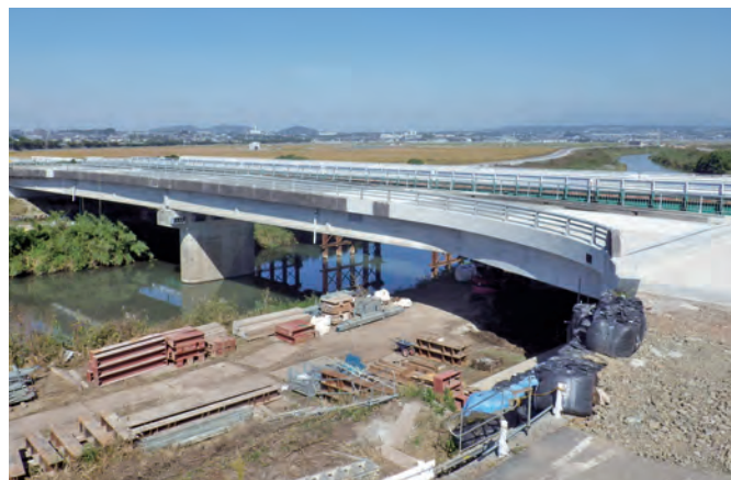
写真-2 復旧完了
