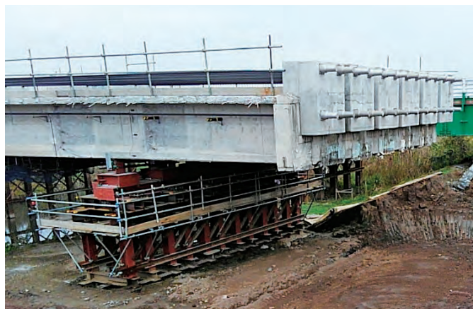
写真-1 外ケーブル補強・仮受け状況
