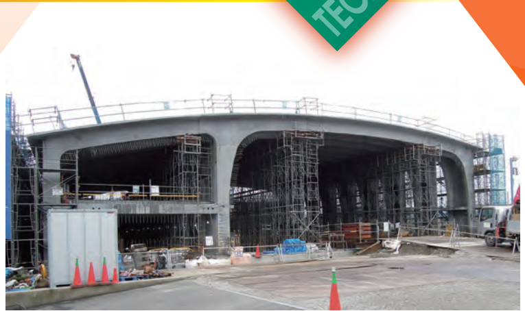
写真-1 建方完了
