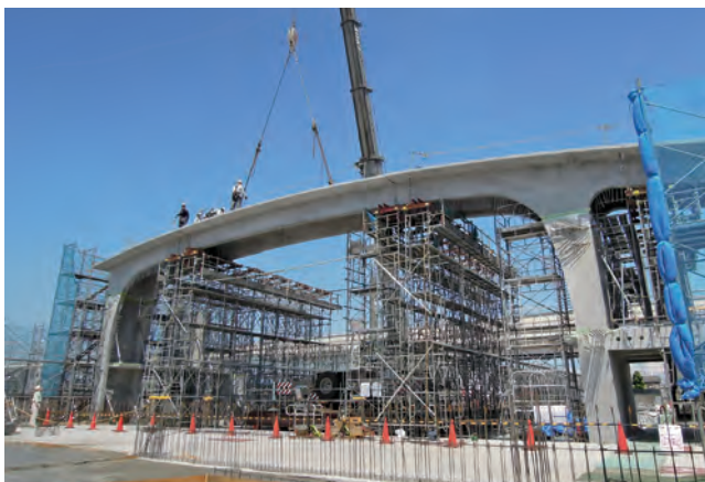
写真-2 屋根梁架設状況
