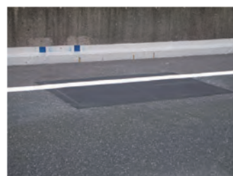
⑧ アスファルト舗装 (完了)
