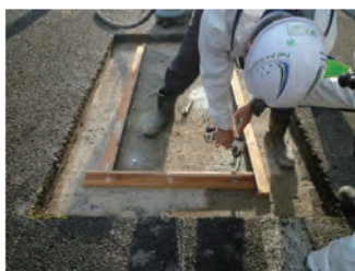
③ アンカー設置
