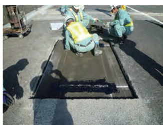
⑦ 床版防水
