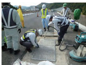
⑥ 型枠脱型、仕上げ
