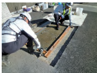
② 型枠組立
