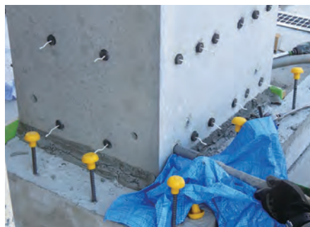
写真-3 モルタル注入
