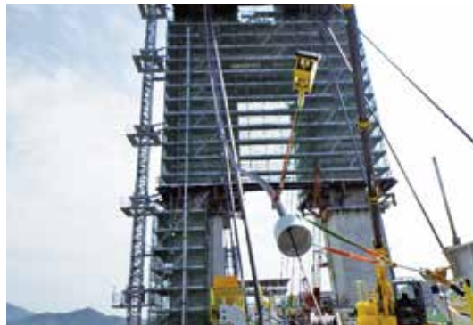
写真-6 保護管先行架設方式
