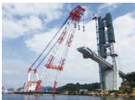
写真-3 FCによる鋼桁架設
