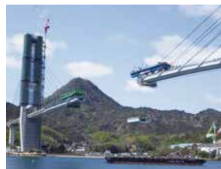
写真-4 エレクションノーズによる鋼桁架設
