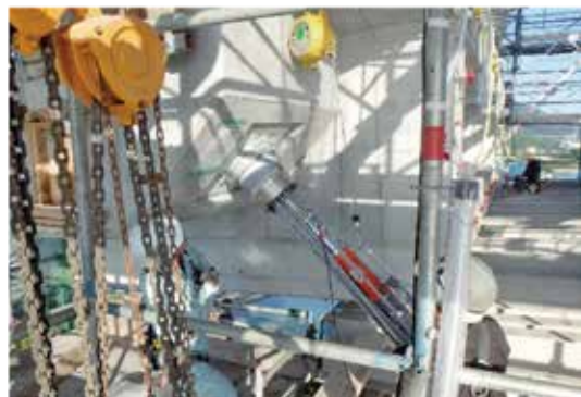
写真-5 斜材ケーブルの緊張
