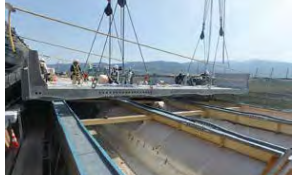
写真-5 壁高欄付きプレキャストPC床版架設状況
