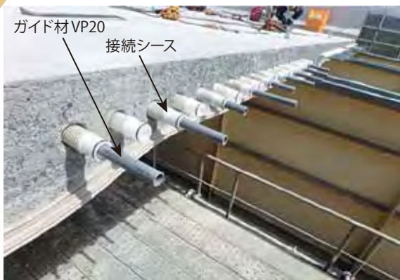
写真-6 接続シースの配置
