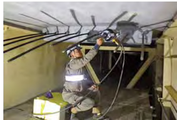
写真-7 定着突起部からのPC鋼材緊張状況
