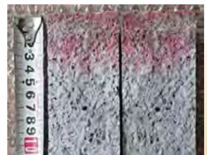
写真-9 目地部コア削孔による漏水確認
