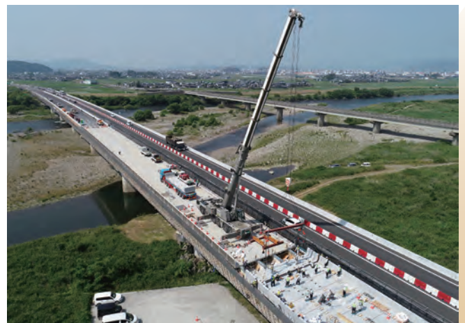
写真-3 プレキャストPC床版架設
