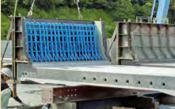
写真-4 壁高欄付きプレキャストPC床版製作状況
