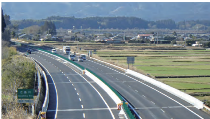
写真-1 池島川橋(上り線)左側【取替え後】
