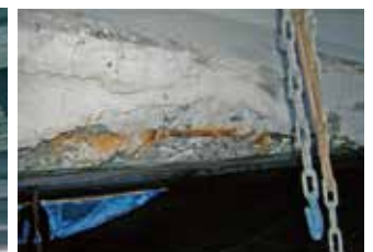
脱塩施工前 再劣化断面修復部
