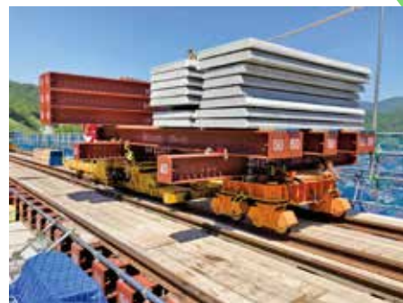
写真-3 重量台車による資材の小運搬
