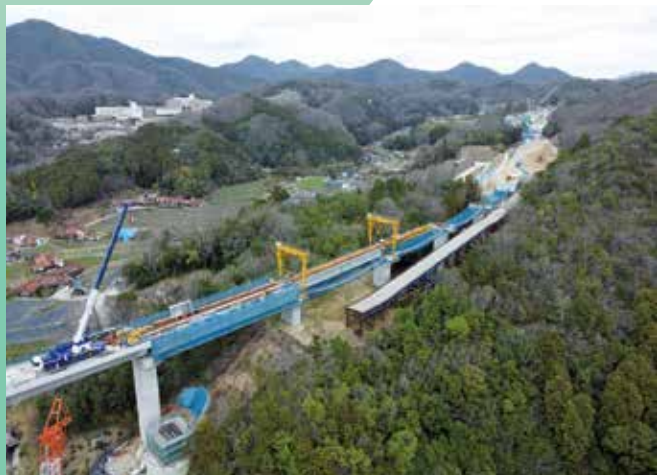
写真-1 施工中全景
