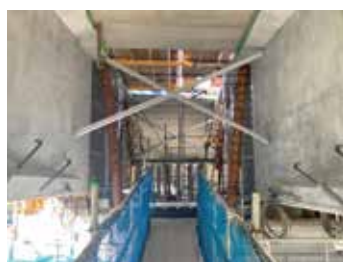
写真-5 桁転倒防止対策
