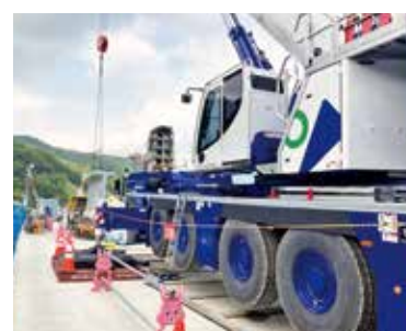
写真-4 250tクレーンによる桁の取卸し
