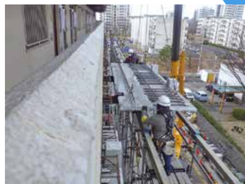
写真-1 従来方法による架設状況
