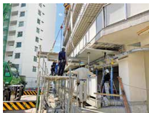
写真-2 吊り治具を用いた架設状況
