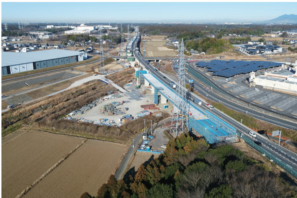
写真-1 施工中全景
