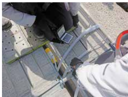
写真-4 充填状況の確認
