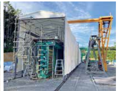
写真一5 移動式上屋設置状況
