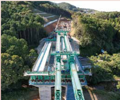
写真一2 二組桁による架設状況
