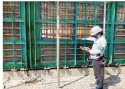
写真一4 コンクリート充填確認(透明型枠)
