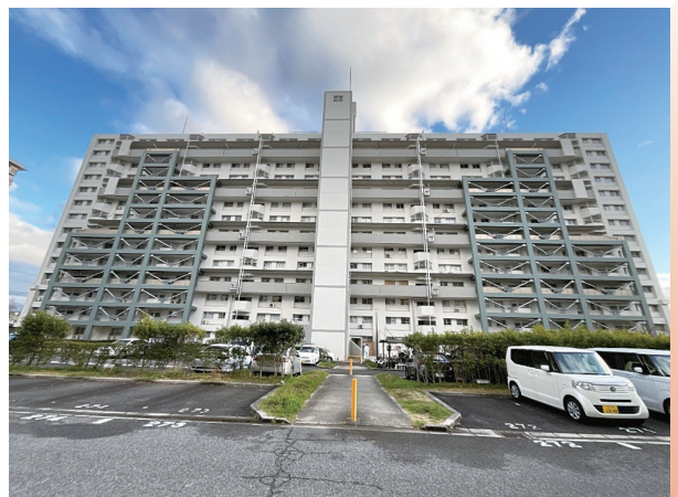
写真-2 耐震補強後建物外観
