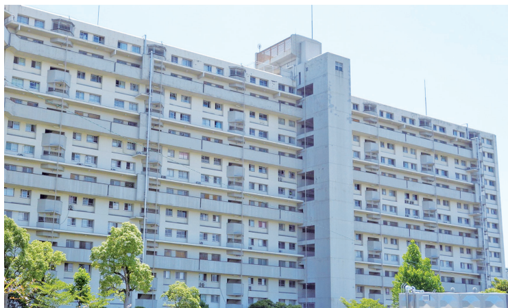
写真-1 耐震補強前建物外観
