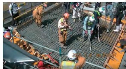
写真-6 CASE2 上床版試験体打設
