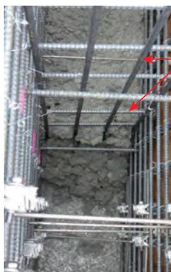
写真-5 CASE1 ウェブ流動抑制鉄筋
