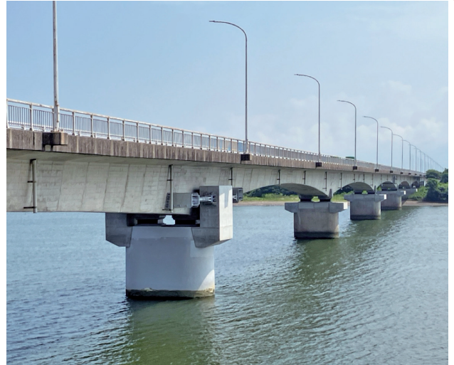
写真-1 完成写真
