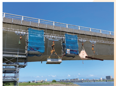
写真-7 資機材運搬用台車
