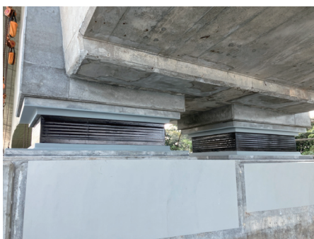
写真-2 支承取替
