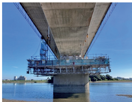
写真-6 ラックレール式移動足場
