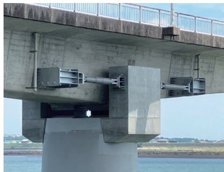
写真-3 制震ダンパー
