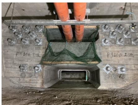
写真-5 落橋防止構造
