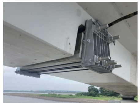
写真-4 変位制限構造
