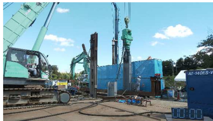
PC矢板の打ち込み状況 (自社敷地内での試験施工)
