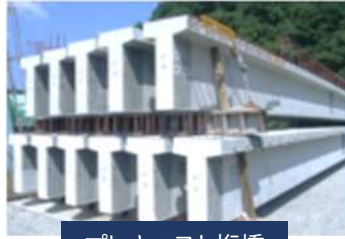
プレキャスト桁橋
